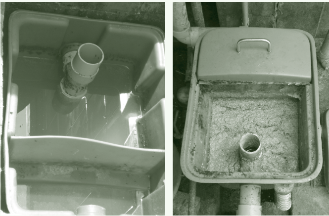
รูปที่ 1.1 ลักษณะน้ำมันและไขมันจากถังดักไขมันในบ้านเรือน
